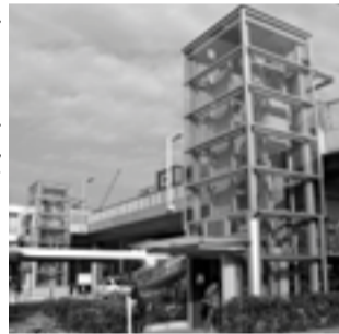
新しく設置されたエレベーター
