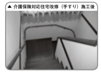
▲介護保険対応住宅改修(手すり)施工後
